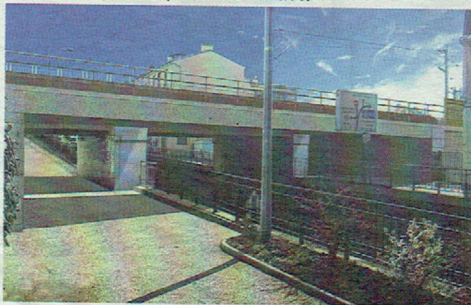
La pose du pont-rail, rue de la Gare se déroulera le week-end du 23 mars 2018. ©Projet Eole
